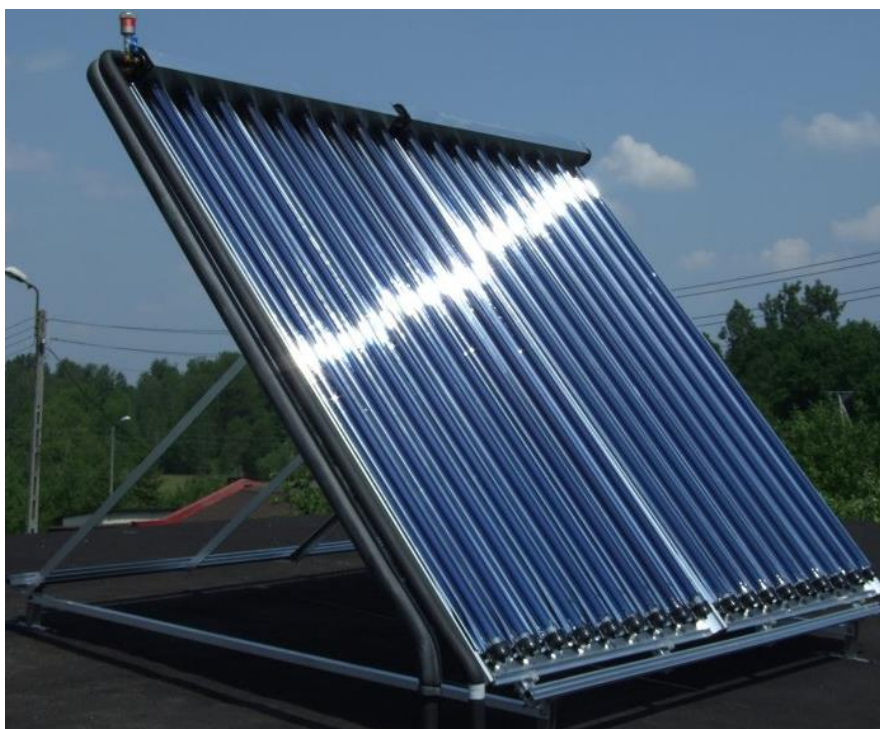
Fig. 1.4 – Colector solar cu tuburi vidate
